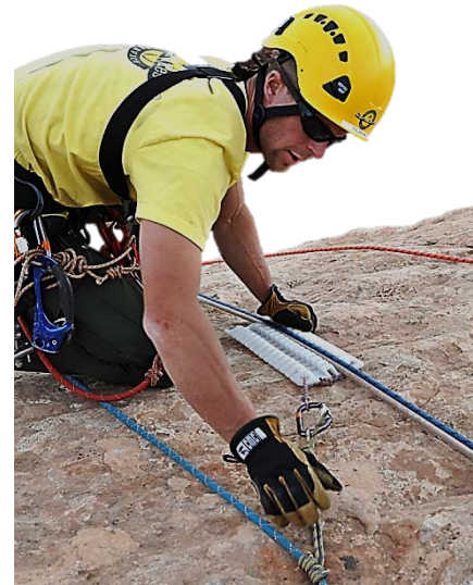
Figure 157- Edge Attendant placing edge protection
